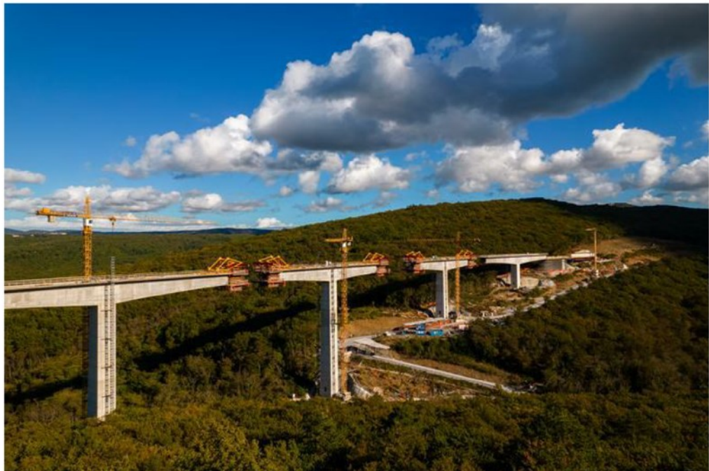
Viadukt Vinjan, ki je bil javnosti predstavljen marca 2024, je gradbeni presežek, ki se razteza 620 metrov v dolžino in ima stebre, ki v višino merijo do 55 metrov. Skupaj z viaduktom Gabrovica igra ključno vlogo pri gradnji drugega tira železniške proge Divača–Koper. Za ta dva ambiciozna gradbena projekta, ki sta pomembna nadgradnja slovenske prometne in logistične infrastrukture, je Slovenija iz kohezijskega sklada prejela 80 milijonov evrov. Foto: 2TDK
